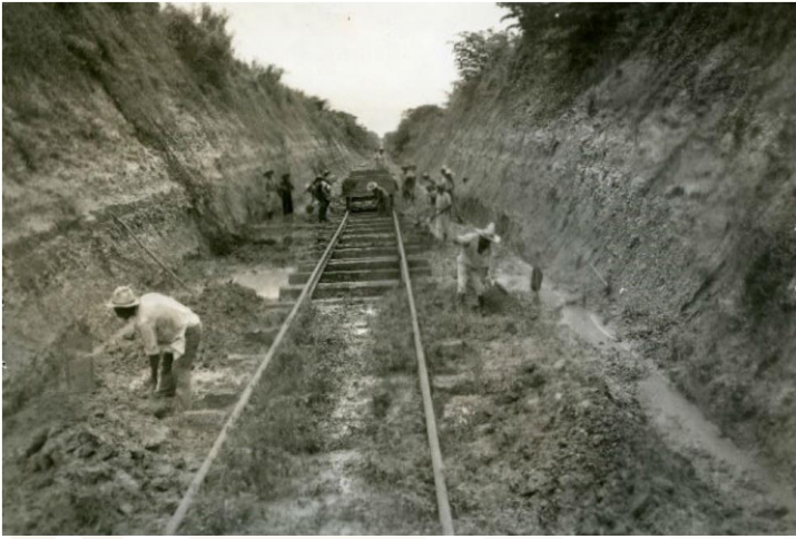
Foto del a construcción de el Tren del Sureste
